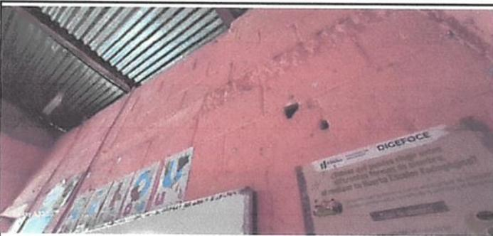
Foto 5: Las paredes necesitan repello
