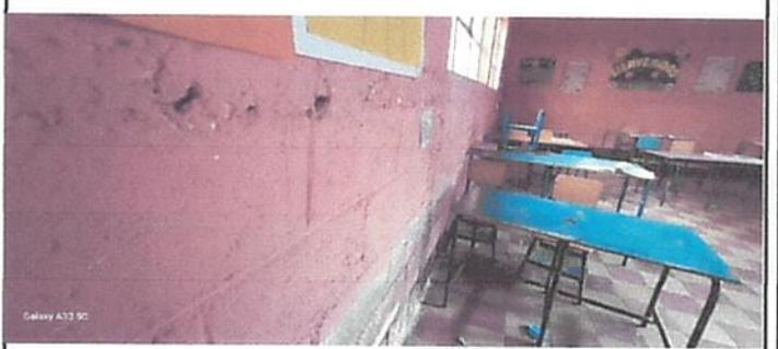
Foto 4: Las paredes de las aulas por dentro necesitan repello por los augeron que poseen
