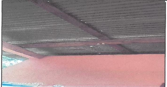
Foto 2: Ac a podemos ver que la madera ya no sirve y la lamina esta muy danada
